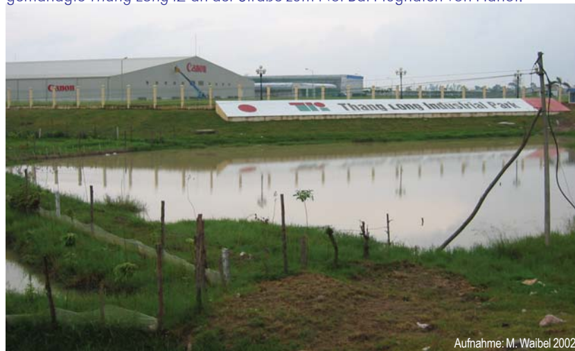
Abb. 3: Die von einem vietnamesisch-japanischen JV-Unternehmen errichtete und gemanagte Thang Long IZ an der Straße zum Noi Bai Flughafen von Hanoi.
